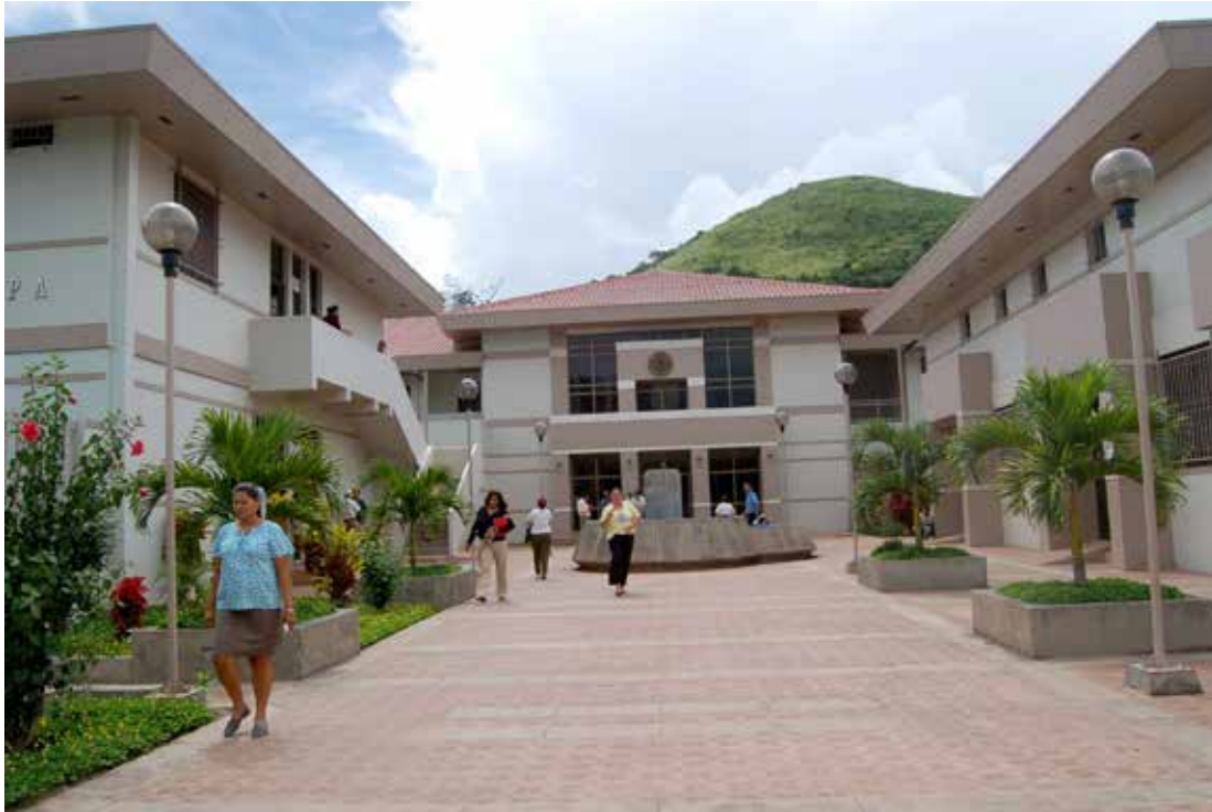
Como parte de la atención a la infraestructura, se dio mantenimiento al Complejo Judicial de Matagalpa.
