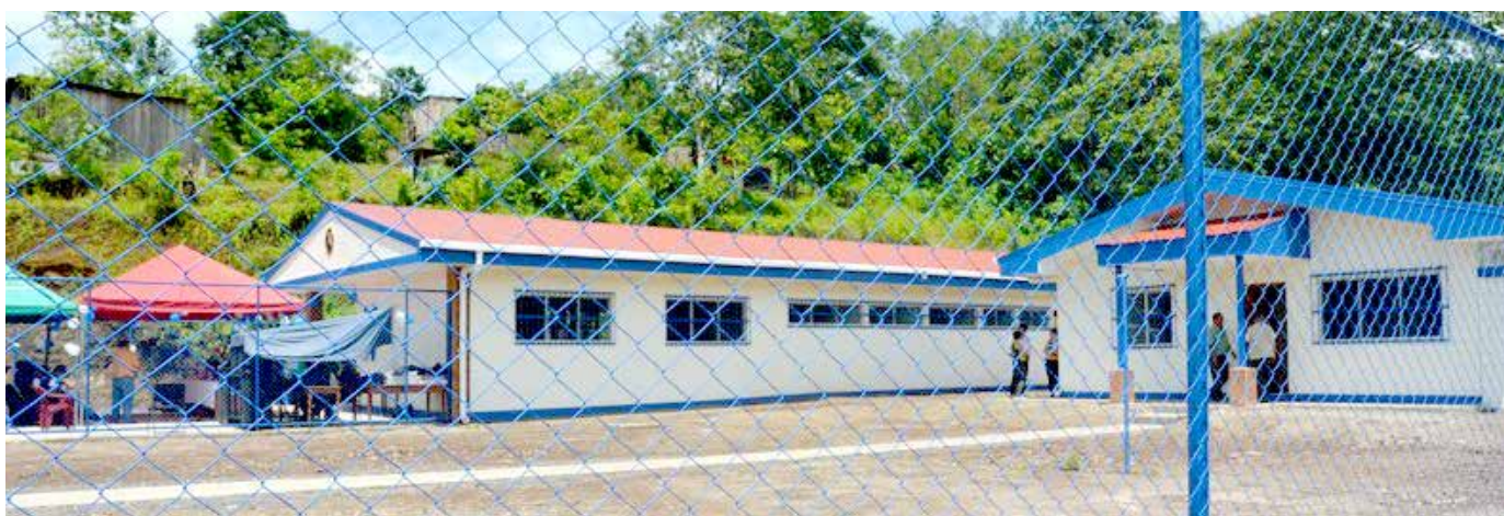
Durante el período 2012-2013 se culminó la construcción de las casas de justicia de San José de Bocay.
