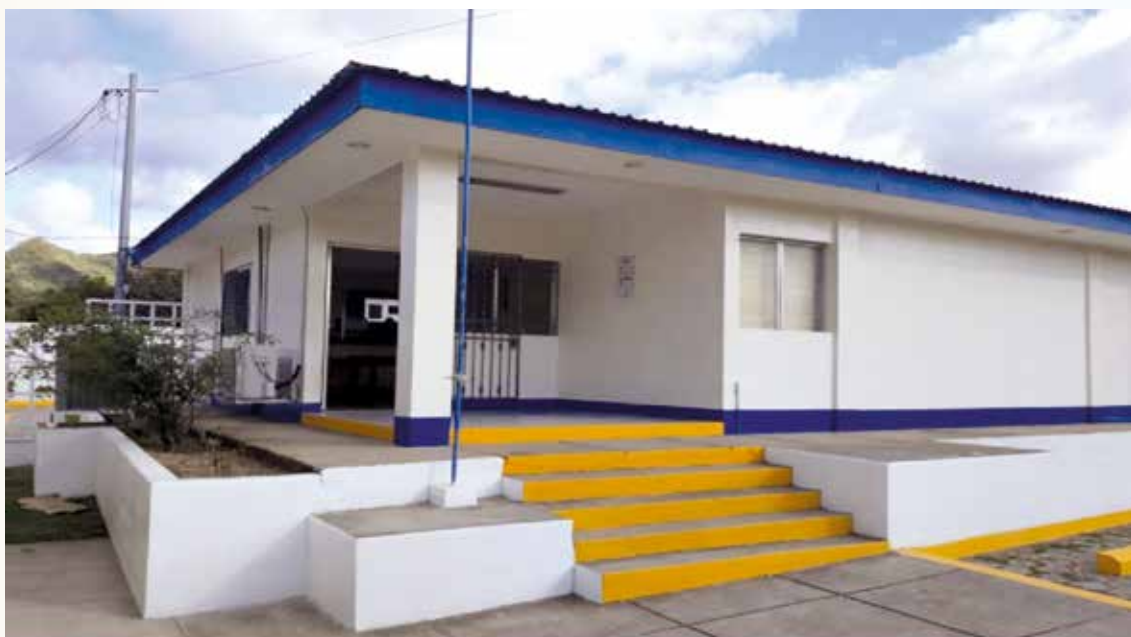
Nuevo edificio del Registro Público del departamento de Madriz.
