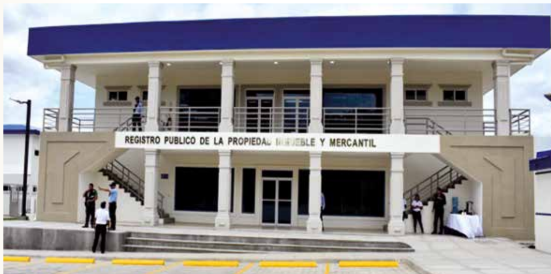
Nuevo edificio del Registro Público de Ocotlán, Nueva Segovia.
