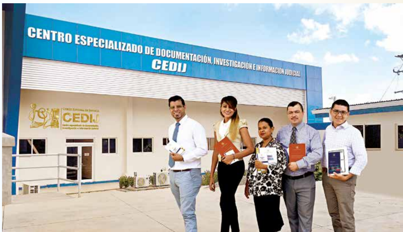
Edificio sede de las nuevas instalaciones del Centro Especializado de Documentación, Investigación e Información Judicial (CEDIJ).
